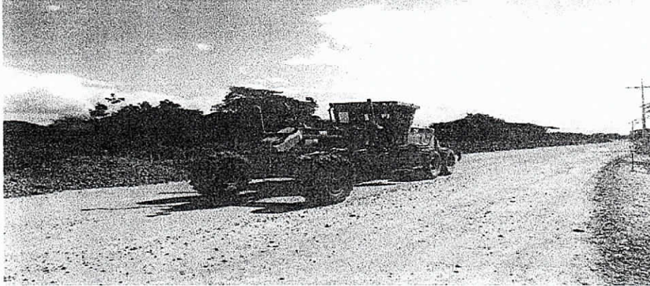
Foto No. 5 Motoniveladora sobre la vía.
