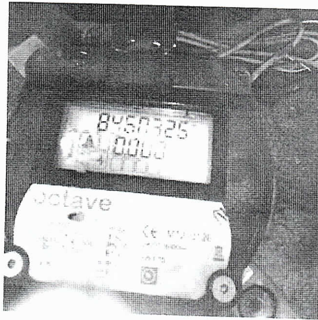
Figura 16. Medidor de caudal instalado en el desarenador de la estación de bombeo No. 1. (Puente Río cañas )
