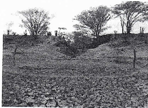
Fotografía 5 Jagüey con daño en el dique
