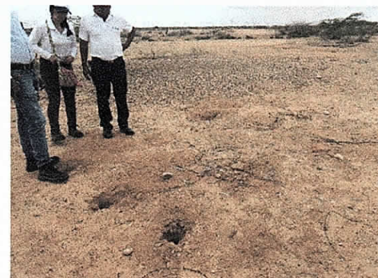
Figura 1. Zona de ubicación torre Casa Eléctrica. Se observan las perforaciones para el hincado de la torre, cerramiento de los vientos, pedazos de alambre de púas y anclajes de los vientos.
