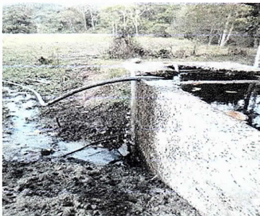
Fotografía 7. Conexión en manguera (2") para el abastecimiento de la finca del cabildo indígena. (Fuente: CORPOGUAJIRA 2019).
