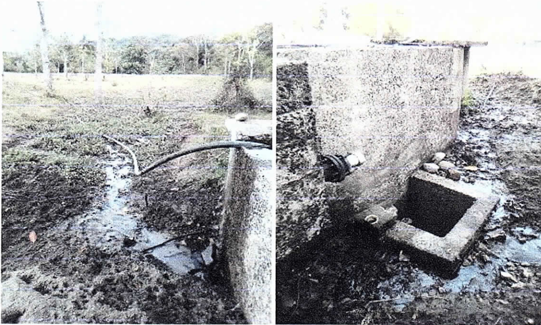
Fotografía 8 Y 9. Fugas de agua en el vertedero y captación ilegal. (Fuente: CORPOGUAJIRA 2019)
