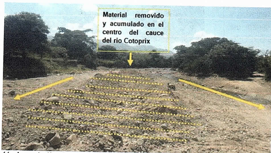
Imagen No 11. Acumulación de material removido en el cauce río Cotoprix generando represamiento y bifurcación de las aguas encausándolas por los lados laterales.
