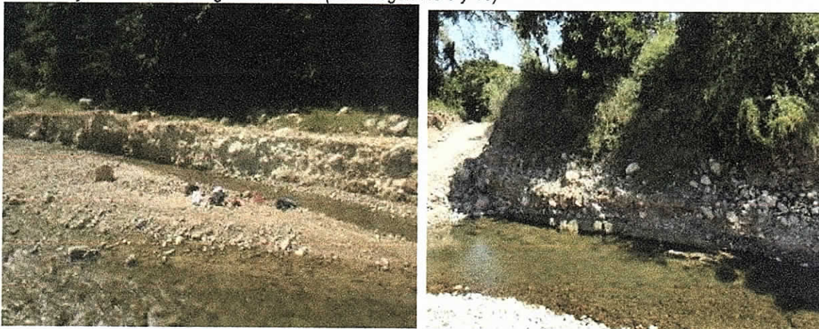
Imagen No 9 y 10. Material rígido del piso del cauce desnudado y removido.
