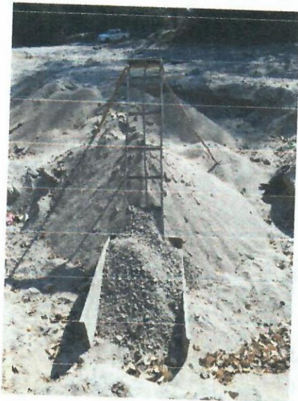
Fig.(3 – 4). Tamices empleados para la granulometria del material
