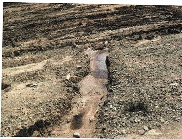
Foto No 42, 43, 44 y 45. Escurrimiento y drenaje de lixiviados desde la cota máxima de las celdas a su base celda 5.
