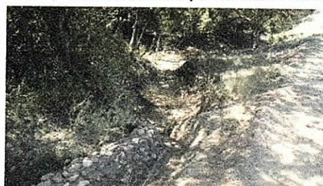
Foto N 6. Acciones correctivas de estabilización de talud. Integración de canales con drenaje natural. Noviembre de 2018
