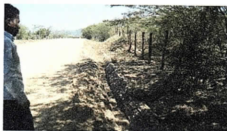
Foto No 5 Noviembre de 2018. En estas se aprecia la estabilidad y buen estado del enrocado en vía de acceso principal.
