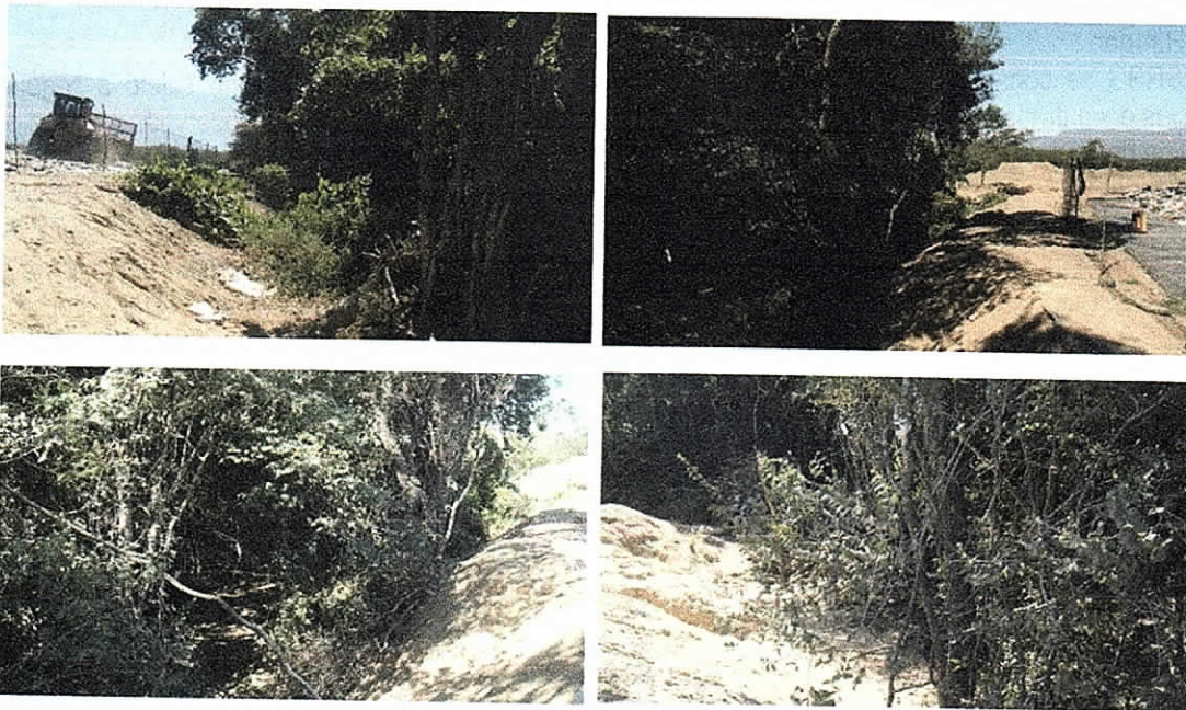
Foto No 51 y 52 Talud de la celda sobre el arroyo Magueyes. Noviembre 30 de 2018.
