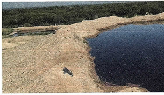
Foto No 14, 15, 16 y 17. Derrame de lixiviado por daño en mangueras y acumulación de estos al borde del talud del celda No 1 con potencial riesgo de desbordamiento. Noviembre 30 de 2018.
