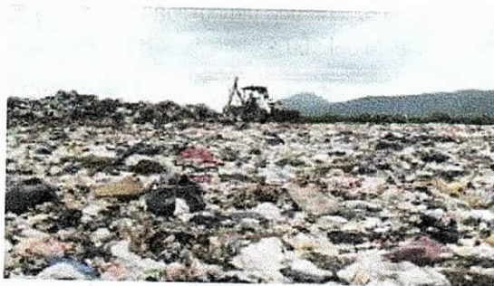
Fotos 25 y 26. Disposición, esparcimiento, homogeneización y compactación de residuos sobre cobertura final de celda No 4, 5 y 6. Junio 8 de 2017
