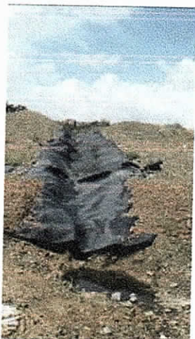
Foto No 42, 43, 44 y 45. Escurrimiento y drenaje de lixiviados desde la cota máxima de las celdas a su base celda 5.
