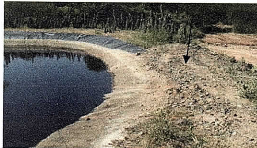
Fotos N 8. Acción correctiva con material terreo para el control del desbordamiento de laguna de lixiviados No 2. Noviembre de 2018
