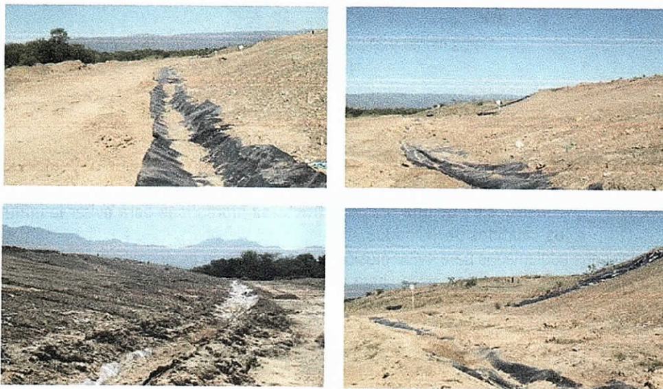
Fotos No 34, 35, 36 y 37. Canales perimetrales. Noviembre 30 de 2018
