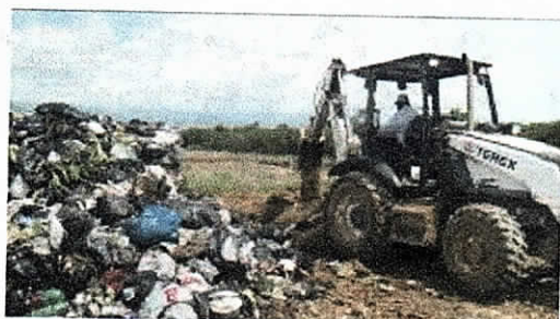
Foto No 46 y 47. Excavación parte superior celda No 3 para control de lixiviados.
