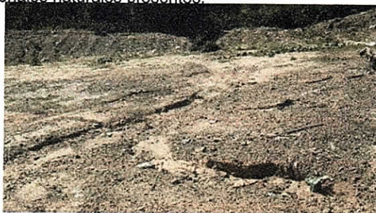
Fotos No 38. Procesos erosivos y libres discurrir de aguas de escorrentías por talud de la celda hasta arroyos naturales. Noviembre 30 de 2018
