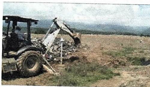
Foto No 46 y 47. Excavación parte superior celda No 3 para control de lixiviados.
