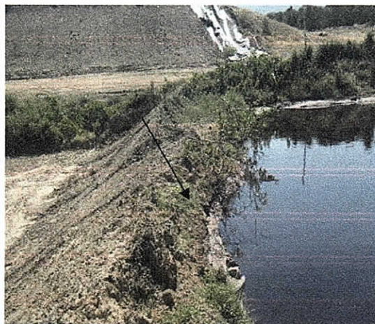
Fotos N 9. Lixiviados en contacto con talud en tierra, laguna de lixiviados No 1, en el RSRSG . Noviembre de 2018
