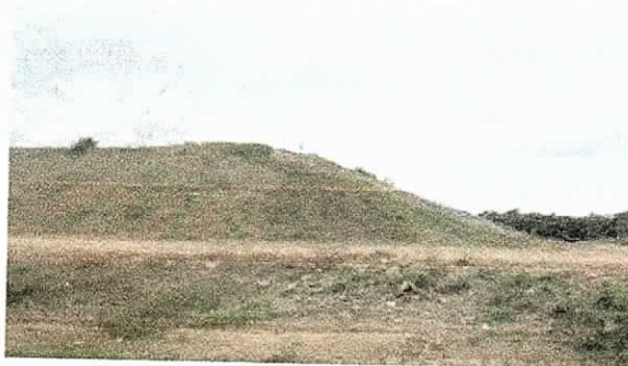
Foto 21. Estabilización de taludes con cobertura vegetal por autogeneración. Junio 8 de 2017
