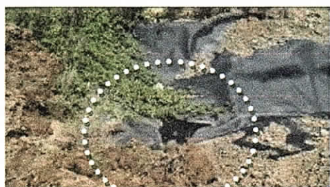
Foto No 38, 39, 40 y 41. Drenaje de lixiviados desde la cota máxima de la celda No 3 a su base.
