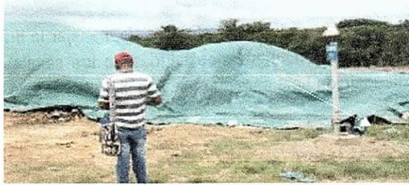
Foto No 48. Punto crítico de lixiviado en celda 3 según inspección de 26 de mayo de 2017, superada.
