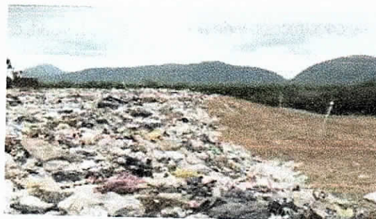
Fotos 25 y 26. Disposición, esparcimiento, homogeneización y compactación de residuos sobre cobertura final de celda No 4, 5 y 6. Junio 8 de 2017
