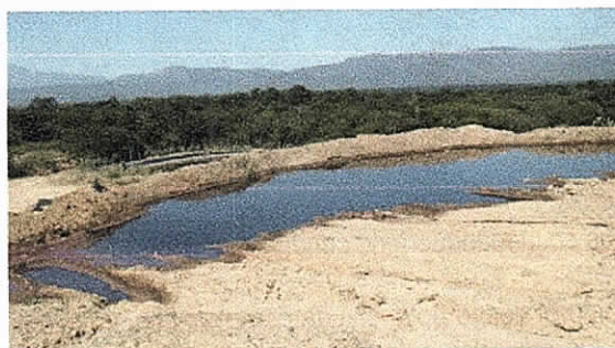
Foto No 14, 15, 16 y 17. Derrame de lixiviado por daño en mangueras y acumulación de estos al borde del talud del celda No 1 con potencial riesgo de desbordamiento. Noviembre 30 de 2018.
