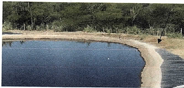
Fotos N 7. Desbordamiento de laguna de lixiviados No 2. Noviembre de 2018
