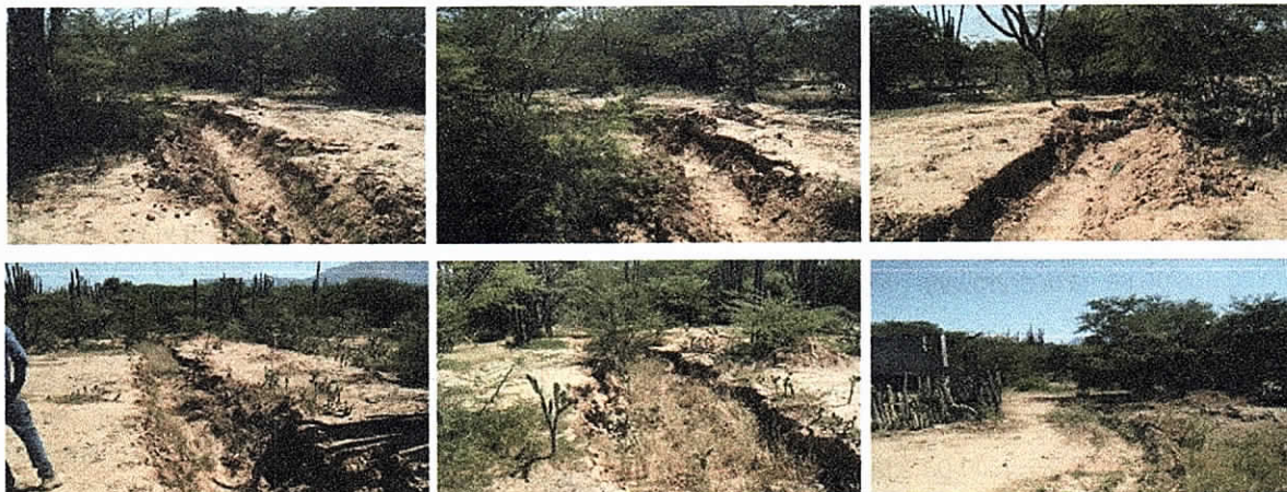
Fotos No 22-27. Proceso erosivo en canal posterior del vivero. Noviembre 30 de 2018
