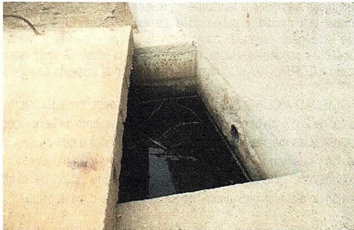
Foto 12: Alberca de lavado de gases sin cubrimiento. DISALMAR, Maicao. 16 de junio de 2017.
