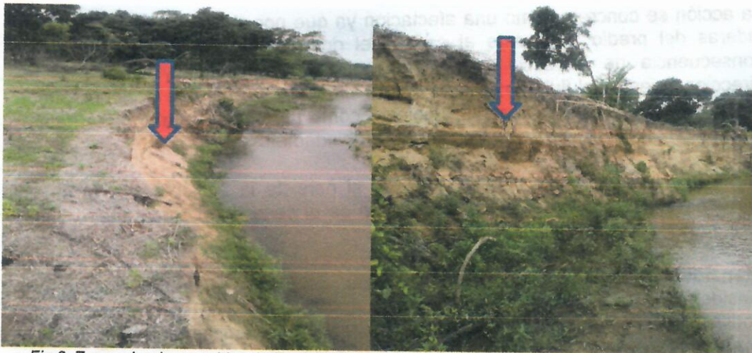
Fig.2. Zonas donde se evidencia Erosión de Taludes margen izquierda cauce Rio Cesar
