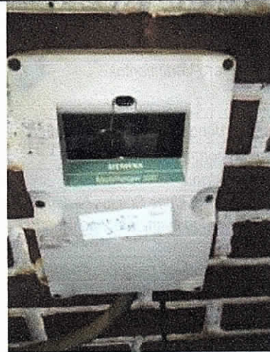
Figura 9. El medidor de caudal y volumen en la salida del sistema.
