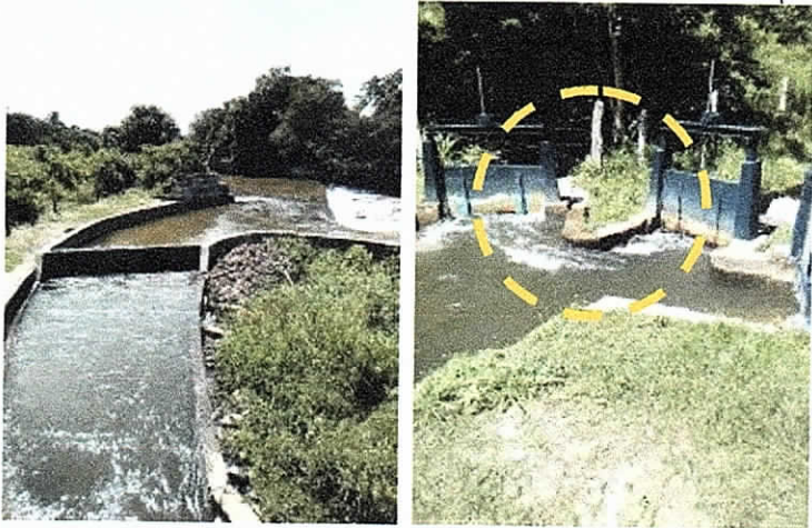
Figuras 10. Canal en la bocatoma y salida de agua de exceso al río en la estructura de control (compuertas).
