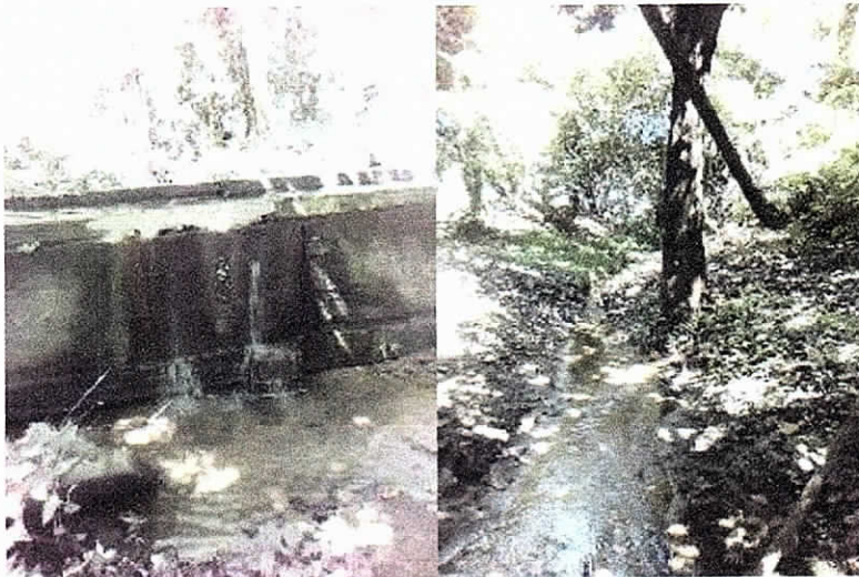
Figuras 12 y 13. Aberturas realizadas sobre la corona del canal de aducción del acueducto del Distrito de Riohacha y acequia receptora del caudal.
