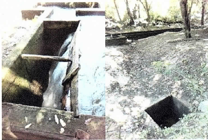
Figura 11. Estructuras para conducción de las aguas de exceso al río Tapias en el Desarenador.
