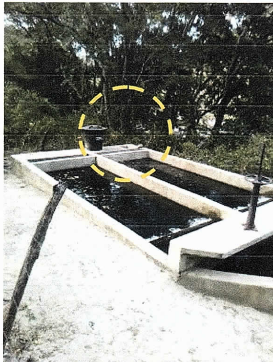
Fotografía 7. Inyección de cloro en la salida del desarenador. (Fuente CORPOGUAJIRA 2019).
