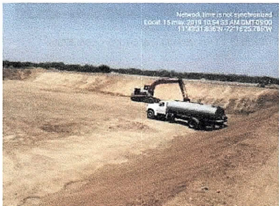
Fotografías No 5 – 8. Reconstrucción De Dique Divisorio Dentro De La Laguna N°5.
