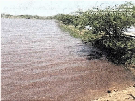
Fotografías No 1 – 4. STAR del municipio de Uribí, aguas residuales de color rosado en algunas lagunas del sistema de tratamiento.
