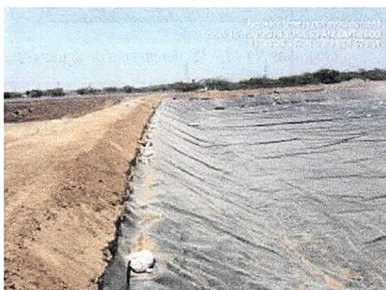
Fotografías No 5 – 8. Reconstrucción De Dique Divisorio Dentro De La Laguna N°5.
