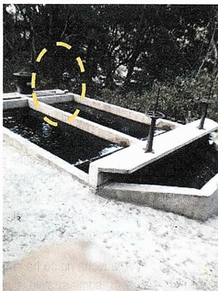
Fotografía 5. Desarenador acueducto regional de Dibulla con tanque dosificador de cloro para su tiramiento. (Fuente CORPOGUAJIRA 2019).
