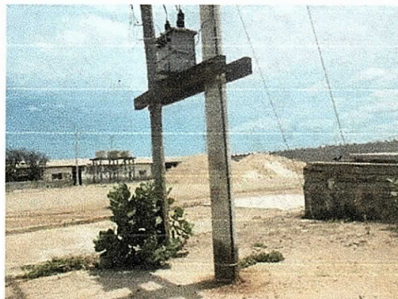
Foto No 12: Equipo tipo Transformador Eléctrico con derrame de aceite aislante, propiedad de la empresa SAMA LTDA. 10 de abril de 2018.
