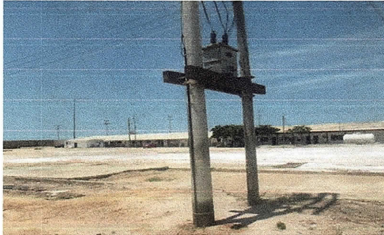
Foto No 17: Equipo tipo Transformador Eléctrico con derrame de aceite aislante, propiedad de la empresa SAMA LTDA. 22 de septiembre de 2017.
