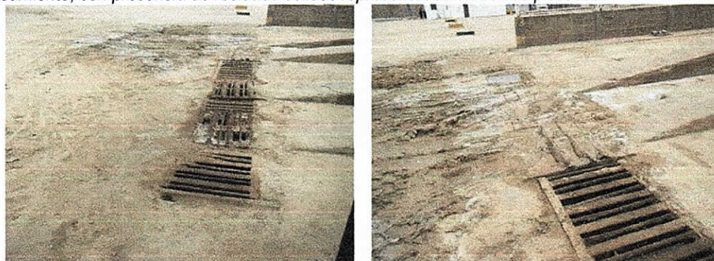
Fotos No 9 y 10: Sedimentador y trampa de grasas de área de lavado. SAMA LTDA. 10 de abril de 2018.
