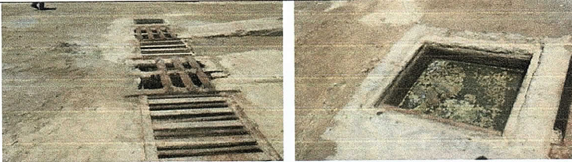
Fotos No 14 y 15: Sedimentador y trampa de grasas de área de lavado. SAMA LTDA. 22 de septiembre de 2017.
