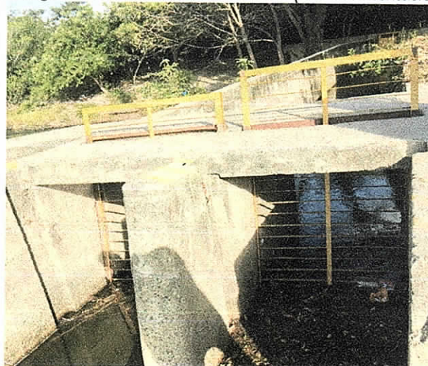
Fotografía 6. Bocatoma canal Robles (alta sedimentación)
