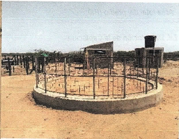
Imagen 3. Estructura para la construcción de reservorio, capacidad 30 m 3
