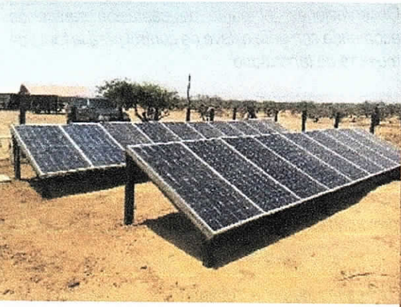
Imagen 4. Paneles solares como fuente de energía de la bomba
