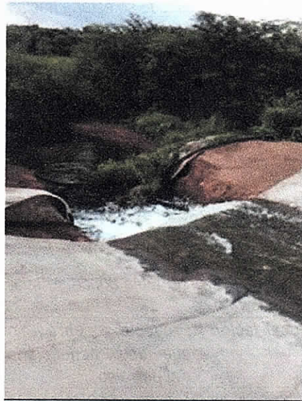
Fotos 3 y 4: Revestimiento del Canal del Embalse Samaleón y final del mismo.
