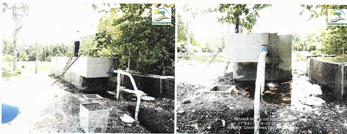
Fotografía 7 y 8. Desarenador Nuevo Acueducto del Corregimiento de Palomino. (Fuente. CORPOGUAJIRA 2019)
