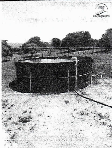
Fotografía 3. Tanque de almacenamiento de agua para el sistema de riego –predio Divino Niño (Fuente: CORPOGUAJIRA 22-08-2019)
