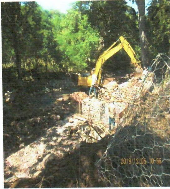
Img. (5-6). Extracción de material rocoso mediante maquinaria (Retroexcavadora)
