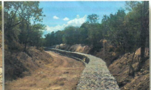
Imagen 26. Material forestal intervenido por maquinaria para la construcción de gaviones, punto 26 Arroyo Pozo Hondo
