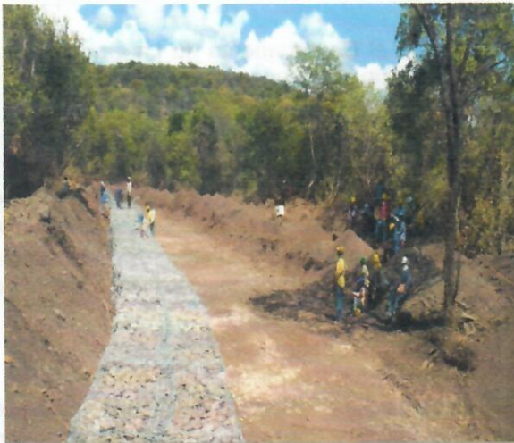
Imagen 26. Material forestal intervenido por maquinaria para la construcción de gaviones, punto 26 Arroyo Pozo Hondo
