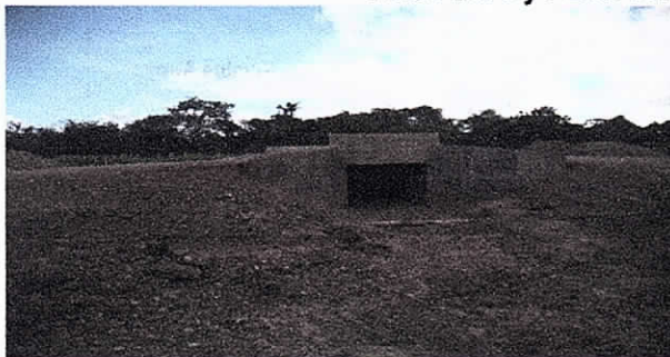
Fotos No. 6 y 7 Box Culvert y rectificación de cauce
