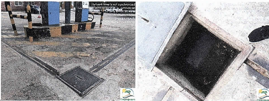
Fotografías No. 16 y 17: canal perimetral. EDS AUTOCENTRO MÓBIL BALLENAS. 18 de octubre de 2019. (Fuente CORPOGUAJIRA)
