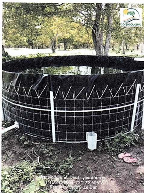
Fotografía 3. Tanque de almacenamiento de agua para el sistema de riego –predio Si le Dan (Fuente: CORPOGUAJIRA 22-08-2019)
