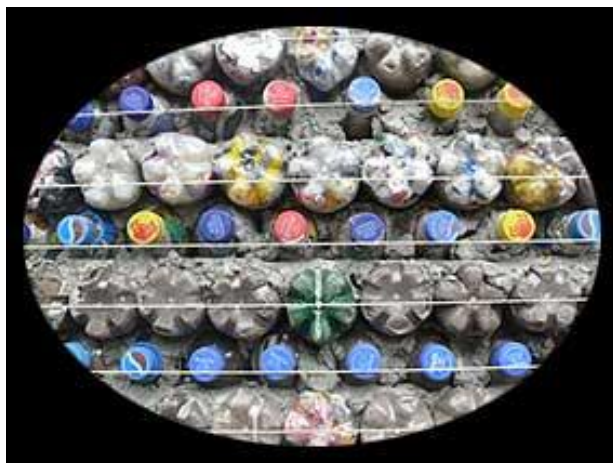
DETALLE DE MURO MOSTRANDO COMO SE ALTERNAN LAS BOTELLAS LA MATRIZ QUE SE FORMA
