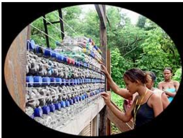
DETALLE DE MURO MOSTRANDO COMO SE ALTERNAN LAS BOTELLAS LA MATRIZ QUE SE FORMA
