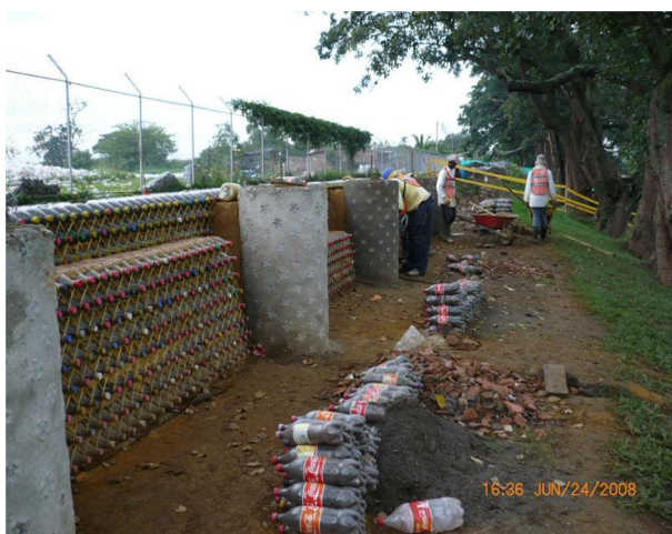
DETALLES CONSTRUCTIVOS CON BOTELLAS DE PLÁSTICO
