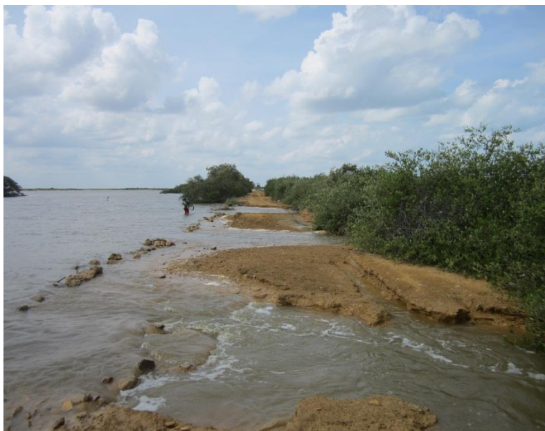
FOTO 37. ABERTURAS HECHAS SOBRE EL CARRETEABLE DE ACCESO AL “MIRADOR” PARA PERMITIR LA SALIDA DE AGUA DEL RESERVORIO SITUADO A SU IZQUIERDA DA
