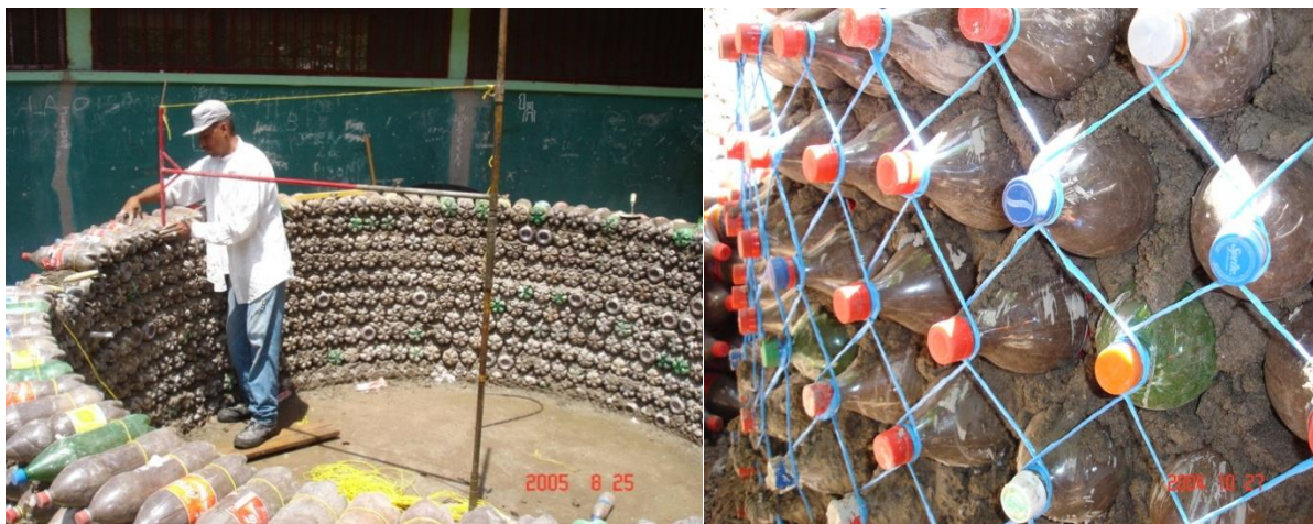
DETALLES CONSTRUCTIVOS CON BOTELLAS DE PLÁSTICO
