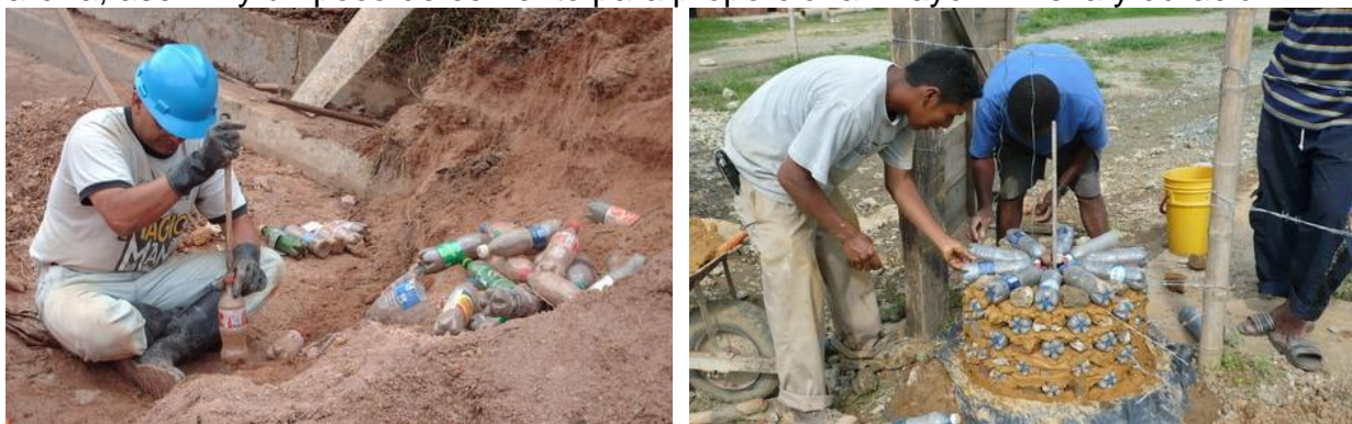
LLENADO DE BOTELLAS Y CONSTRUCCIÓN DE UNA COLUMNA ECO-TEC
