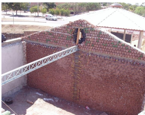
DETALLES CONSTRUCTIVOS CON BOTELLAS DE PLÁSTICO
