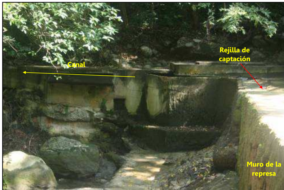
FOTO 23. estructura de captación del acueducto de Maicao..
