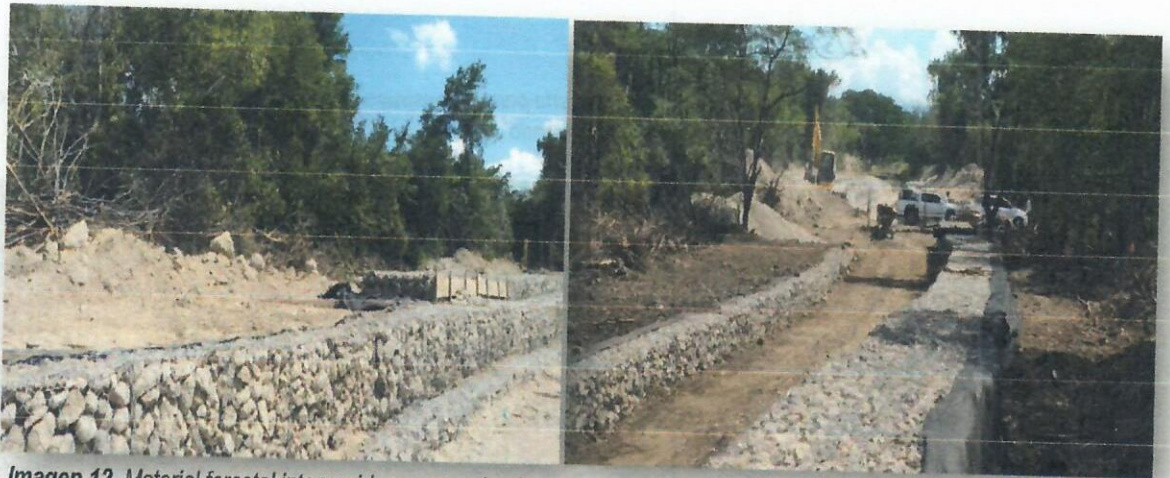
Imagen 12. Material forestal intervenido por maquinaria para la construcción de gaviones, punto 12, Arroyo Pozo Hondo
