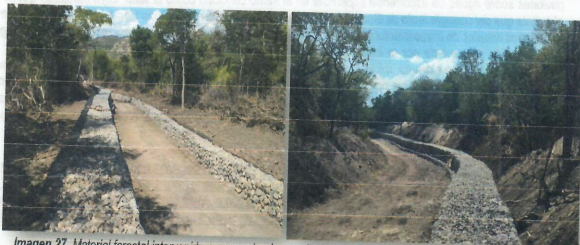
Imagen 27. Material forestal intervenido por maquinaria para la construcción de gaviones, punto 27 Arroyo Pozo Hondo
