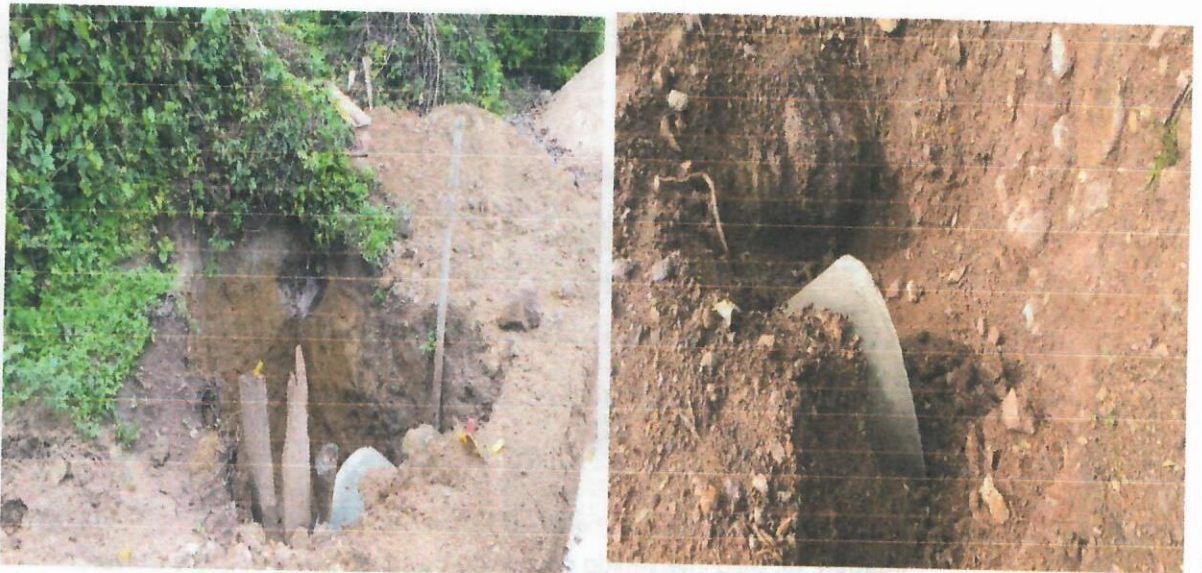
Imagen 7. Sitio intervenido ocupación de cauce punto 6, Box's Culverts
