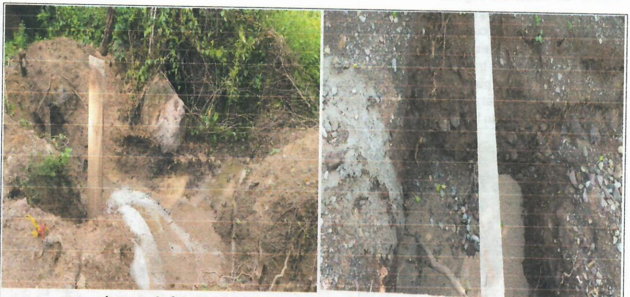
Imagen 8. Sitio intervenido ocupación de cauce punto 7, Box's Culverts
