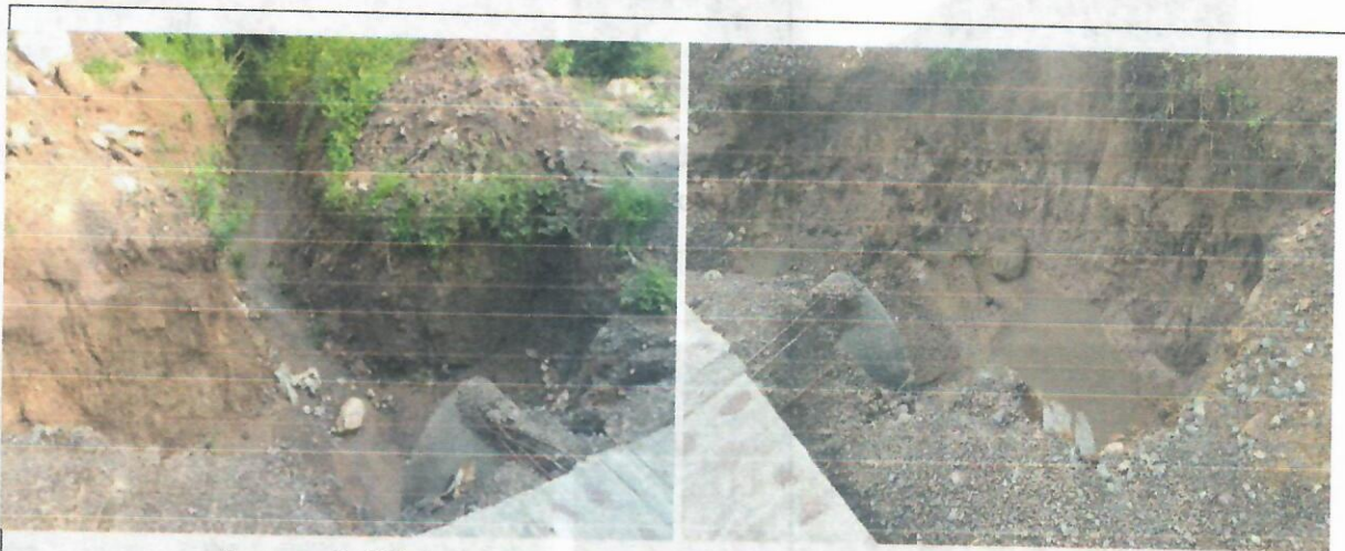
Imagen 3. Sitio intervenido ocupación de cauce punto 2, Box's Culverts
