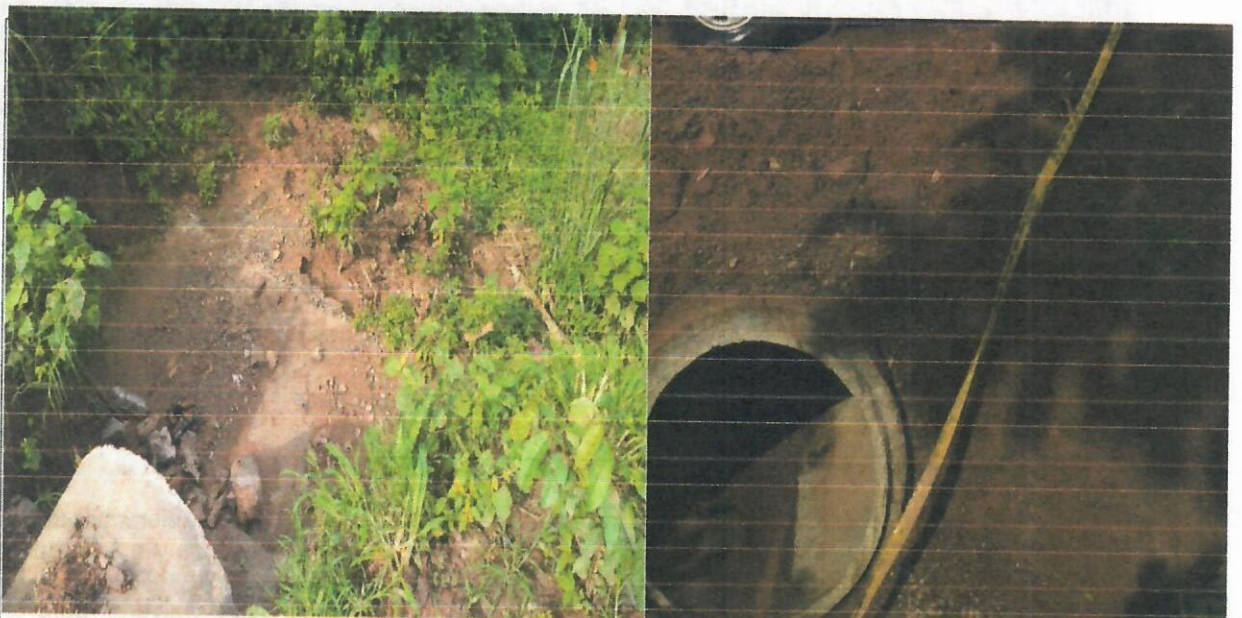
Imagen 9. Sitio intervenido ocupación de cauce punto 8, Box's Culverts
