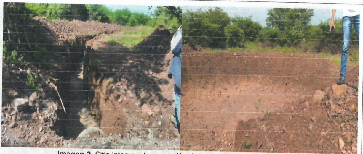
Imagen 2. Sitio intervenido ocupación de cauce punto 1, Box's Culverts
