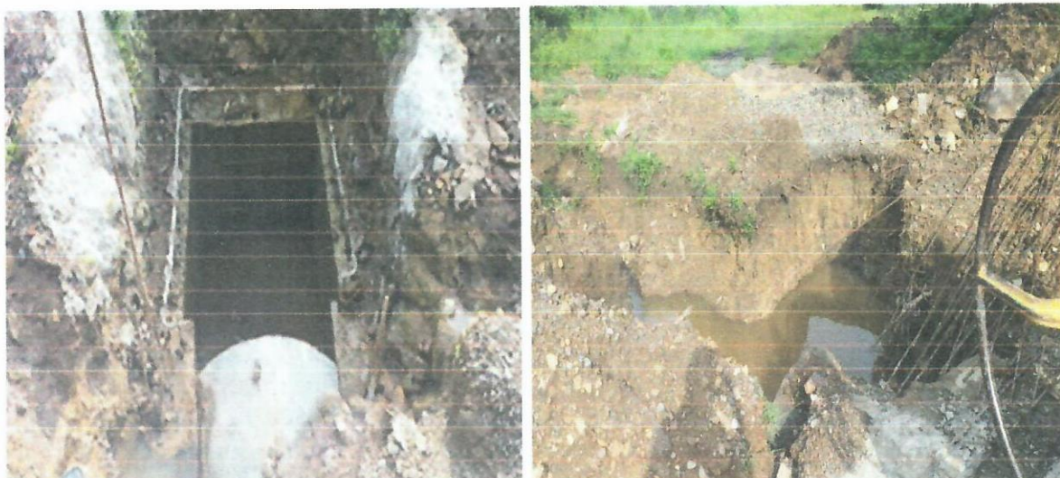
Imagen 10. Sitio intervenido ocupación de cauce punto 9. Box's Culverts
