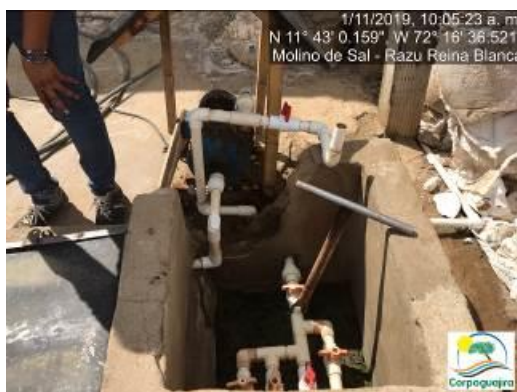
Fotografías No. 3 y 4. Derivación de Toma de Muestra de Agua en la Obra de Captación de Aguas Subterráneas. RAZU REYNA BLANCA S.A.S. 01 de Noviembre de 2019. (Fuente: Corpoguajira 2019).
