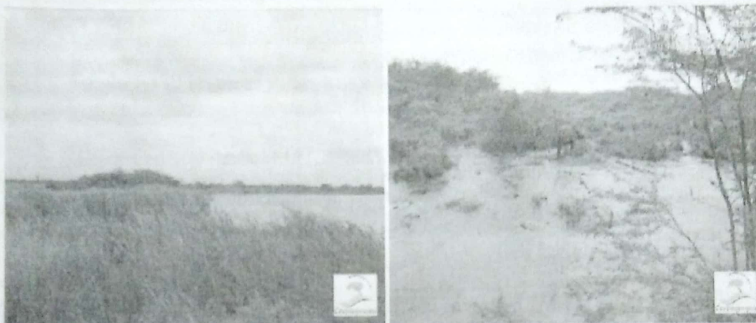
FOTOGRAFÍAS No 1 - 2. Laguna de oxidación limoncito. Sistema de tratamiento de aguas residuales colmatado de lodos y presencia de material vegetal y animales dentro del sistema. Seguimiento realizado en Junio de 2019.
