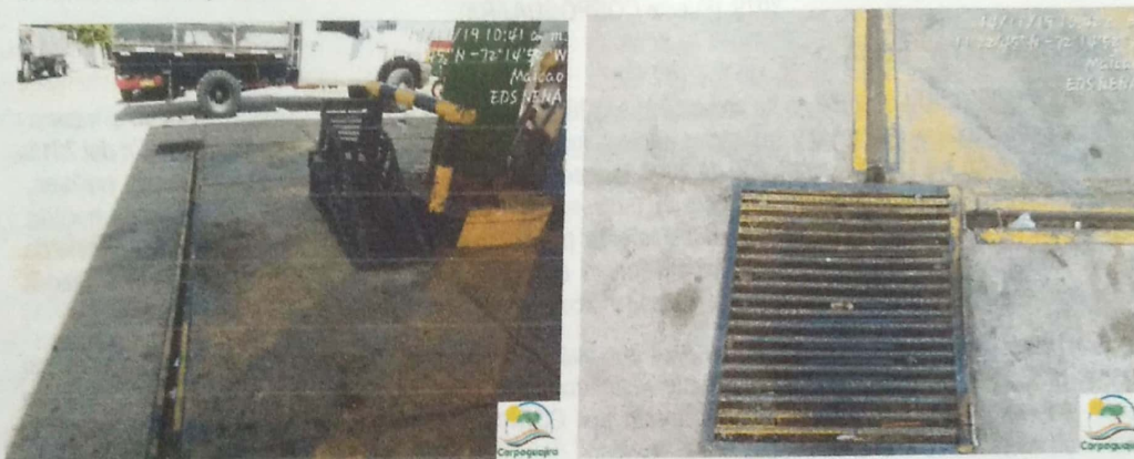
Fotografías No. 15 – 16: canal perimetral y cajilla de recolección. ESTACIÓN DE SERVICIO LA NENA. 14 de noviembre de 2019. (Fuente CORPOGUAJIRA)
