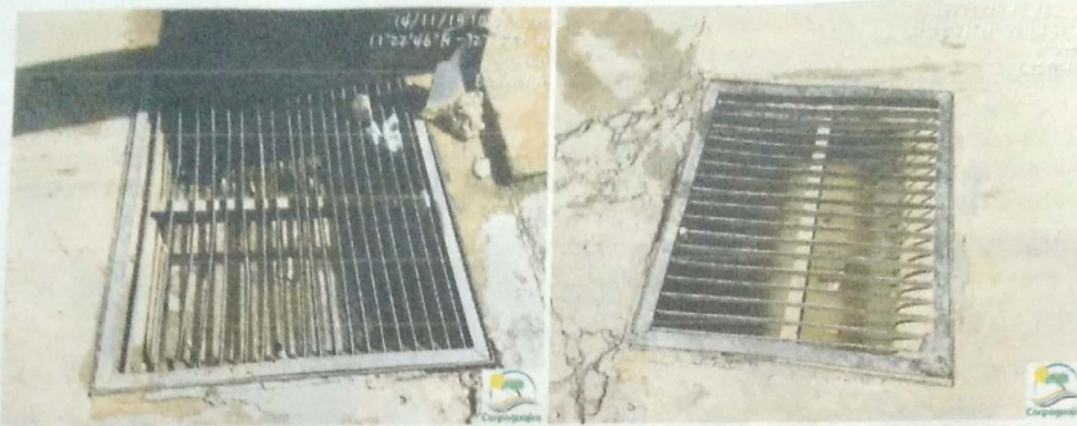
Fotografías No. 11 – 14: Canal de recolección y trampa de grasas. ESTACIÓN DE SERVICIO LA NENA. 14 de noviembre de 2019. (Fuente CORPOGUAJIRA)
