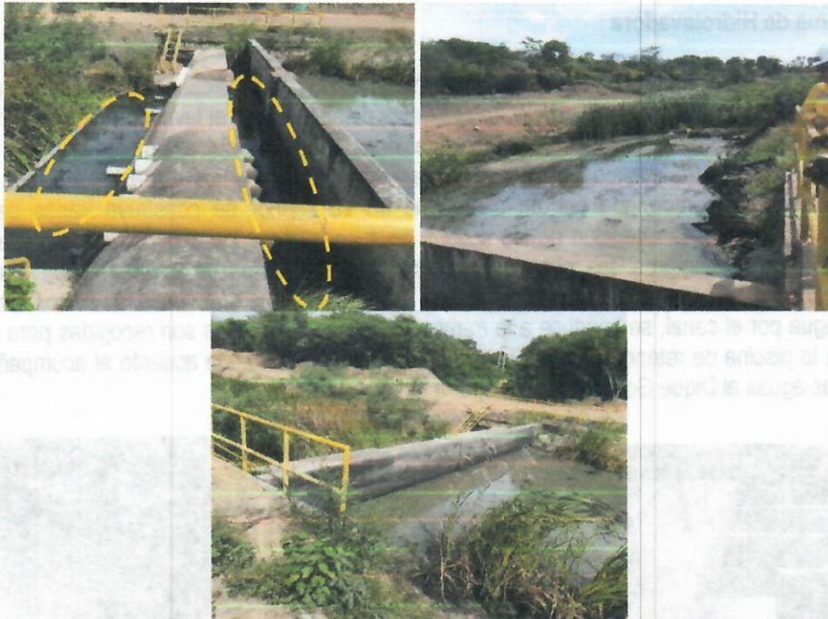
Fotografías No. 24 a 26. Dique Jairo Gonzáles, diques sobre el canal y sistema de sifones. CARBONES DEL CERREJON LIMITED – CERREJON. 17 de junio de 2019.
