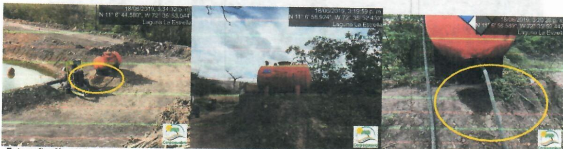
Fotografías No. 105 a 106. Derrame de aceite proveniente del tanque de almacenamiento. CARBONES DEL CERREJON LIMITED – CERREJON. 18 de junio de 2019.
