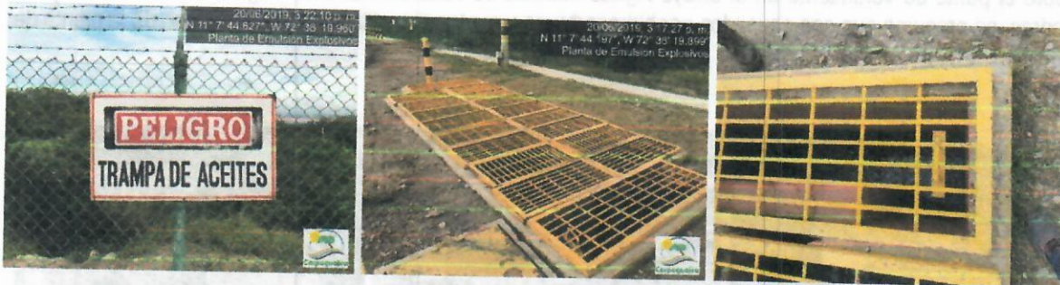
Fotografías No. 212 a 214. Sistema de trampa de grasa planta de emulsión. CARBONES DEL CERREJON LIMITED – CERREJON. 18 de junio de 2019
