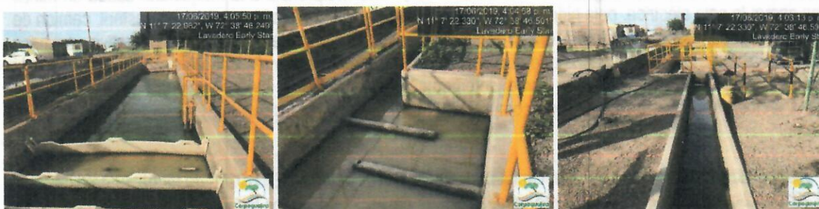
Fotografías No. 36 a 41. Sistema de retención de grasas y sedimentos. Early Star. CARBONES DEL CERREJON LIMITED – CERREJON. 17 de junio de 2019
