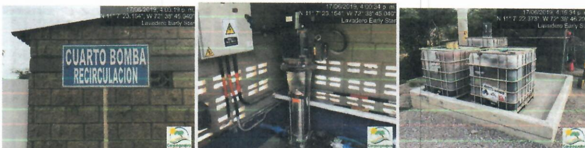
Fotografía No. 33 y 34 Cuarto de bomba. Fotografía 35 Contención de hidrocarburo. Early Star. CARBONES DEL CERREJON LIMITED – CERREJON. 17 de junio de 2019
