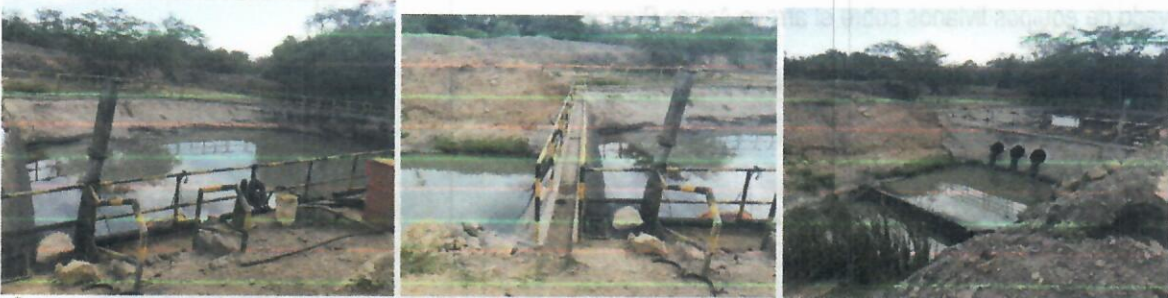
Fotografías No. 21 a 23. Dique Jairo Gonzáles, piscina de retención de grasas y aceites. CARBONES DEL CERREJON LIMITED – CERREJON. 17 de junio de 2019.
