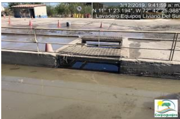
Fotografías No. 13 y 14. Trampas colmatadas de lodos y ARnD resultantes del lavado en zona de Tanques Sépticos Talleres. CARBONES DEL CERREJON LIMITED – CERREJON. COMPLEJO MINA. 03 de diciembre de 2019. (Fuente: Corpoguajira 2019).
