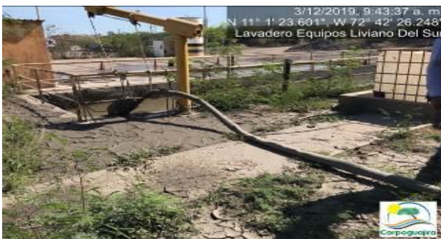
Fotografías No. 15 y 16. Bomba y manguera para evacuar las ARnD resultantes del lavado en zona de Tanques Sépticos Talleres. CARBONES DEL CERREJON LIMITED – CERREJON. COMPLEJO MINA. 03 de diciembre de 2019. (Fuente: Corpoguajira 2019).
