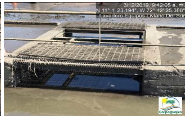
Fotografías No. 13 y 14. Trampas colmatadas de lodos y ARnD resultantes del lavado en zona de Tanques Sépticos Talleres. CARBONES DEL CERREJON LIMITED – CERREJON. COMPLEJO MINA. 03 de diciembre de 2019. (Fuente: Corpoguajira 2019).
