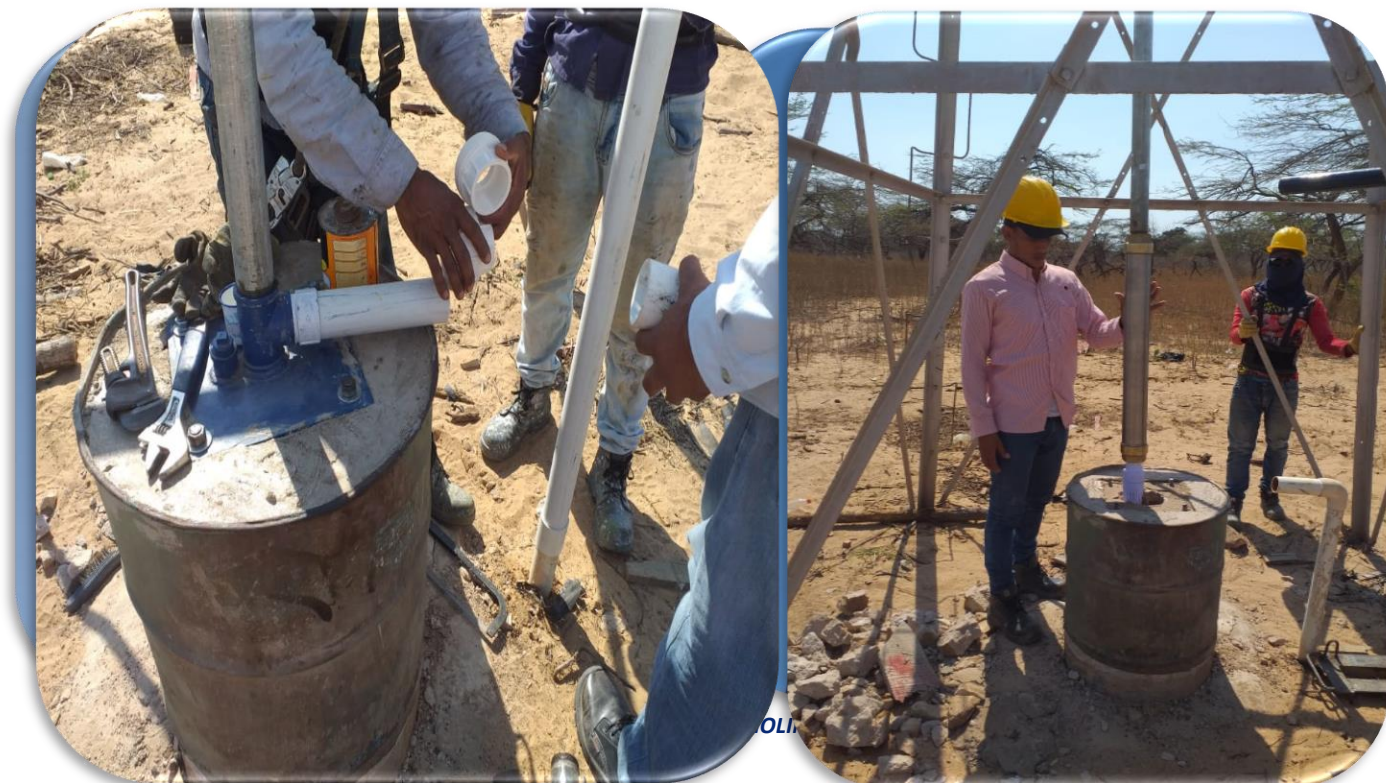
IMAGEN 4. LIMPIEZA Y REPARACIÓN DE POZOS.
