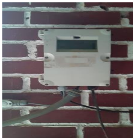
Fotografía 2. Sistema de medición de caudal en la entrada a la PTAP del Distrito de Riohacha. . (Fuente. ASAA. S.A E.S.P 2020)
