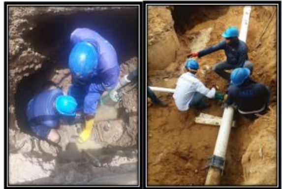
Fotografías 18 y 19. Atención de fugas de agua (Fuente: ASAA S.A E.S.P –Informe de cumplimiento 2019).
