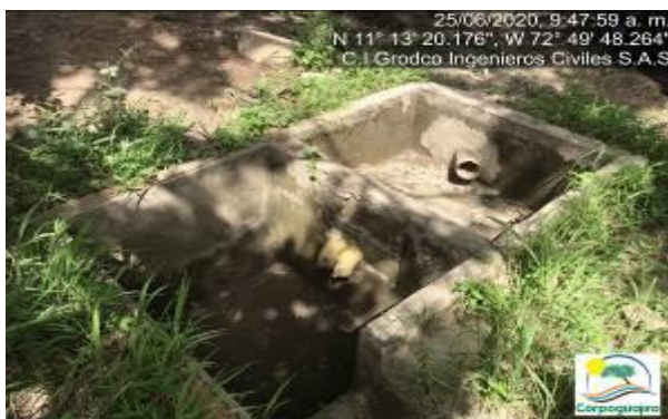
Fotografías No. 19 y 20. Sistema de recolección de aguas residuales no domesticas ARnD. C.I GRODCO INGENIEROS CIVILES S.A.S. 25 de junio de 2020. Fuente: CORPOGUAJIRA 2020.
