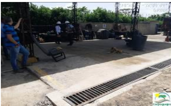
Fotografías No. 15 y 16. Canal y trampa de recolección de residuos líquidos, área de talleres. C.I GRODCO INGENIEROS CIVILES S.A.S. 25 de junio de 2020. Fuente: CORPOGUAJIRA 2020.
