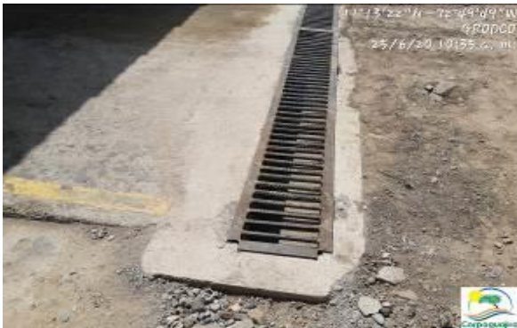
Fotografías No. 13 y 14. Canal y trampa de recolección de residuos líquidos, área de talleres. C.I GRODCO INGENIEROS CIVILES S.A.S. 25 de junio de 2020. Fuente: CORPOGUAJIRA 2020.
