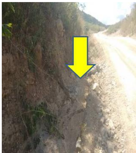
Foto 22: Canal perimetral a vía interna. MINERA LA MILAGROSA – LA MACUIRA. 11 de mayo de 2017.
