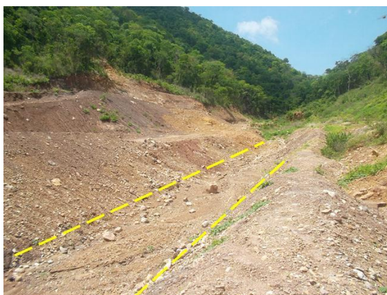
Foto 23: Canal para encausamiento de aguas de escorrentía. MINERA LA MILAGROSA – AGREGOM LTDA. 11 de mayo de 2017.
