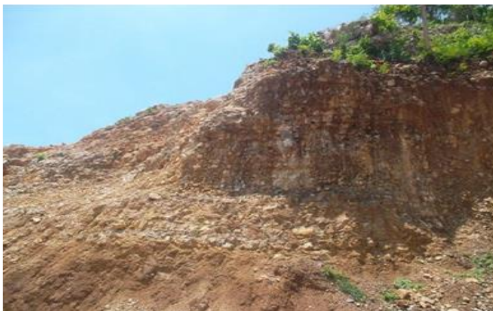
Foto 8: Talud con altura superior a la permitida. MINERA LA MILAGROSA – AGREGOM LTDA. 11 de mayo de 2017.
