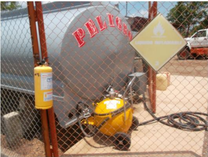
Foto 19: Tanque para almacenamiento de combustibles. MINERA LA MILAGROSA – AGREGOM LTDA. 11 de mayo de 2017.
