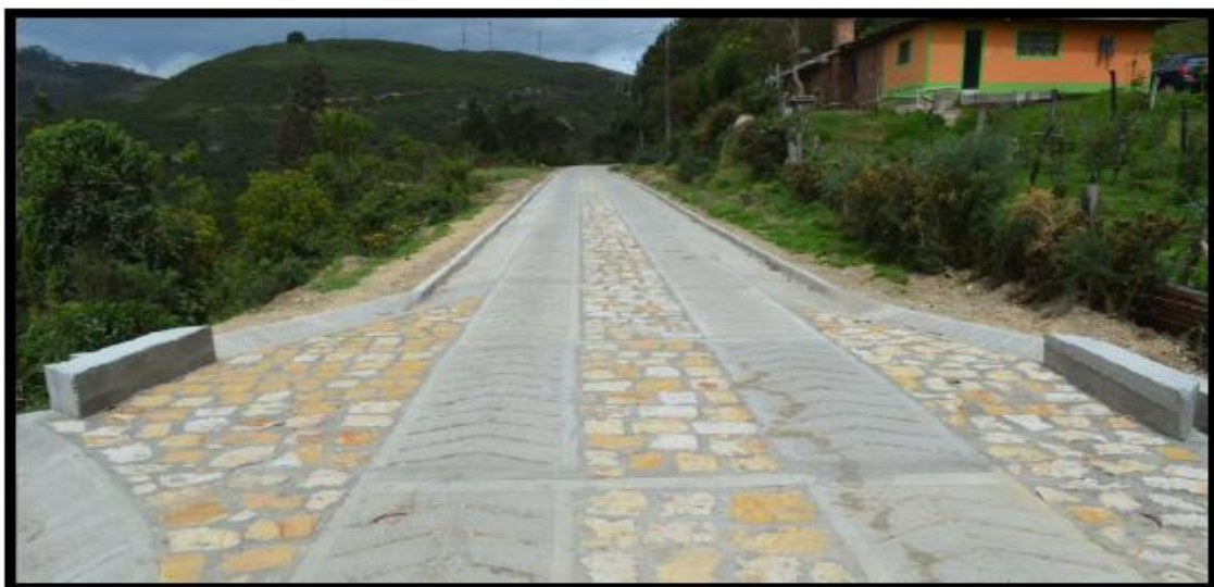
Imagen No 4. Ejemplo de placa huella terminada Fuente: Guía de diseño de pavimentos con placa huella INVIAS
