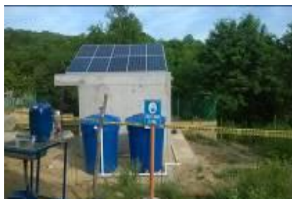
MEJORA Y READECUACIÓN AL SISTEMA EXISTENTE (EN EJECUCIÓN)
