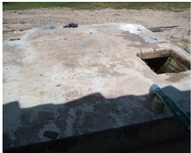
Imagen 3. Deposito de agua cruda tipo alberca
