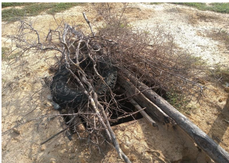
Fotografia 5. Pozo tipo aljibe abandonado, ocasionando riesgo de accidentes y foco de contaminacion
