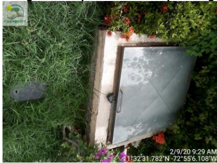
Fotografía 7 Tapa metálica Tanque de agua
