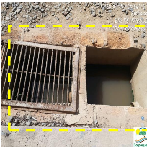
Fotografías No.15-18: Canal de conducción y trampa de grasa, lavadero 1. EDS PETROZULIA . 15 de julio de 2020. (Fuente CORPOGUAJIRA)
