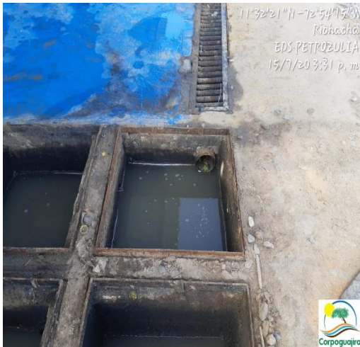
Fotografías No.19-22: Canal de conducción y trampa de grasa, lavadero 2. EDS PETROZULIA . 15 de julio de 2020. (Fuente CORPOGUAJIRA)
