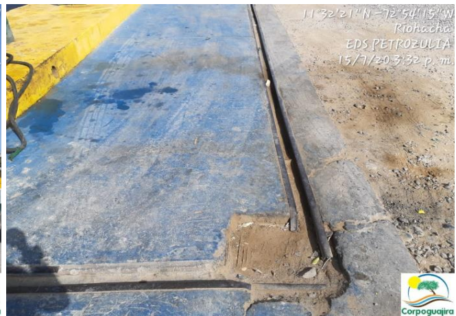
Fotografías No.11-12: canal perimetral de surtidores. EDS PETROZULIA. 15 de julio de 2020. (Fuente CORPOGUAJIRA)
