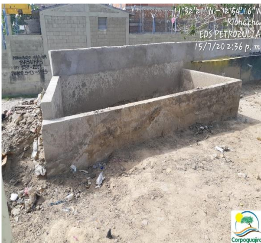
Fotografía No. 23-24: Casta de lodos y lodos retirados de la caseta. EDS PETROZULIA . 15 de julio de 2020. (Fuente CORPOGUAJIRA)
