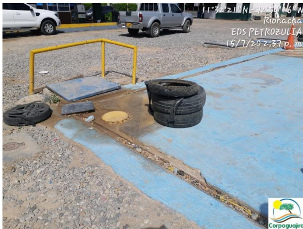
Fotografías No.13-14: canal perimetral de los tanques de almacenamiento de combustible. EDS PETROZULIA. 15 de julio de 2020. (Fuente CORPOGUAJIRA)
