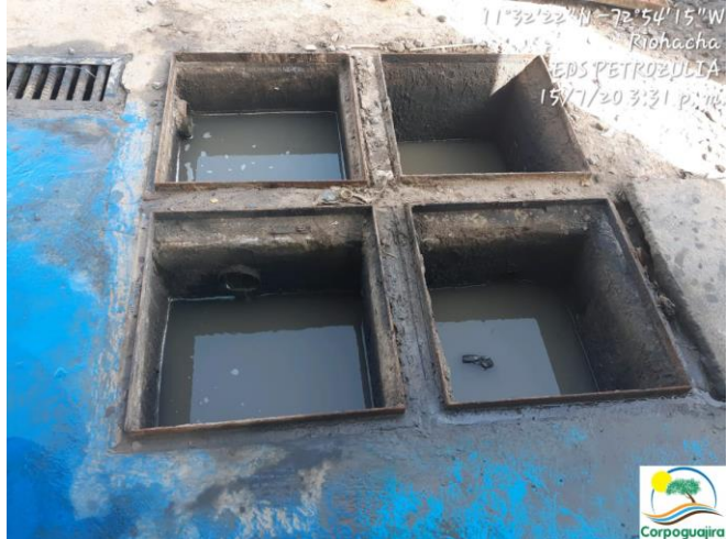
Fotografías No.19-22: Canal de conducción y trampa de grasa, lavadero 2. EDS PETROZULIA . 15 de julio de 2020. (Fuente CORPOGUAJIRA)
