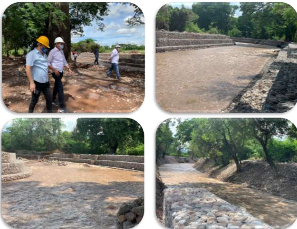
IMAGEN 26. Construcción obras de protección Río Cargabarros en el Municipio de El Molino.
