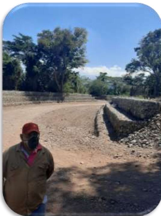
IMAGEN 28. Construcción obras de protección Río Cargabarros en el Municipio de El Molino.
