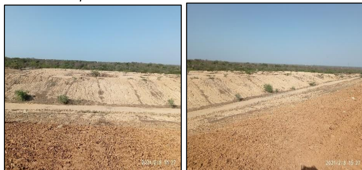
Fotos 67 y 68. Celdas con arbustos aislados y restauración ambiental. 3 de febrero 2021. Fuente CORPOGUAJIRA
