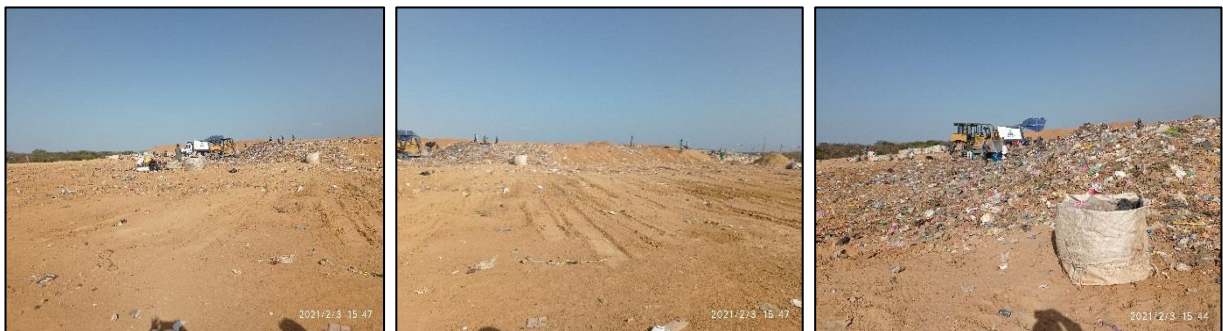
Fotos 35, 36 y 37 Área de disposición diaria sin cubrir, con equipo buldócer para homogenización y compactación y actividad de reciclaje. 3 de febrero 2021. Fuente CORPOGUAJIRA
