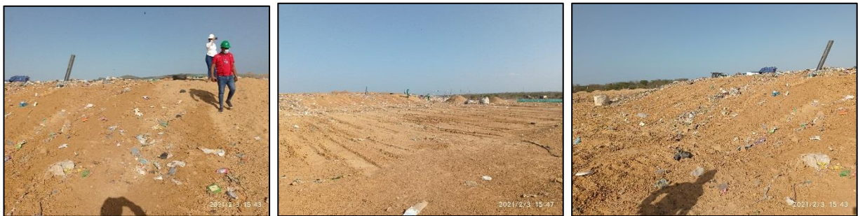
Fotos 32, 33 y 34. Cubrimiento de celdas activas con material terreo. 3 de febrero 2021. Fuente CORPOGUAJIRA
