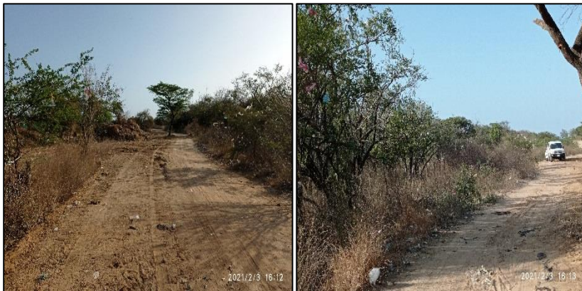
Fotos 11 y 12. Limpieza y mantenimiento de vías 3 de febrero 2021. Fuente CORPOGUAJIRA
