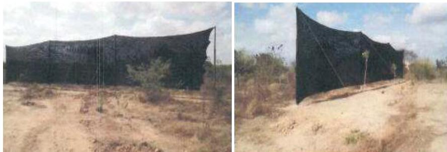
**Fotografías No. 03 y 04.** Instalación de una cortina en polisombra temporal ubicada en la parte de mayor impacto de material particulado en dirección a la Institución Educativa y Comunidad. (Fuente: ENT-1925 de 2021 ORION ASFALTOS & CONCRETOR S.A.S)
