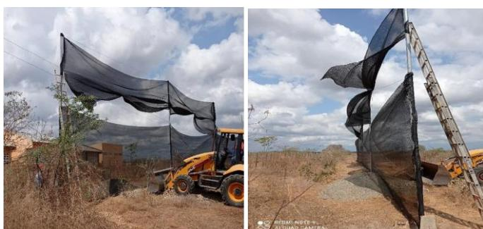
**Fotografías No. 01 y 02.** Instalación de una cortina en polisombra temporal ubicada en la parte de mayor impacto de material particulado en dirección a la Institución Educativa y Comunidad. (Fuente: ENT-1575 de 2021 ORION ASFALTOS & CONCRETOR S.A.S)
