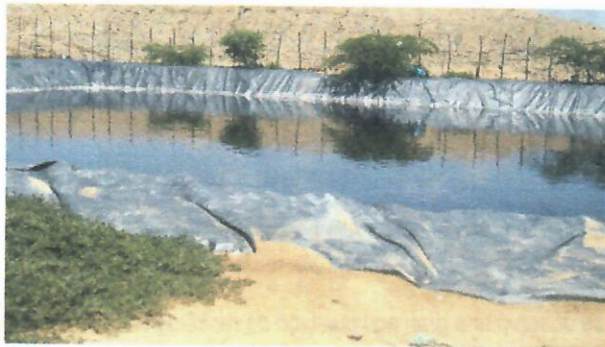
Foto No 48 Fecha: 9 de septiembre de 2019. Laguna de lixiviados con presencia de fugas en mangueras.
