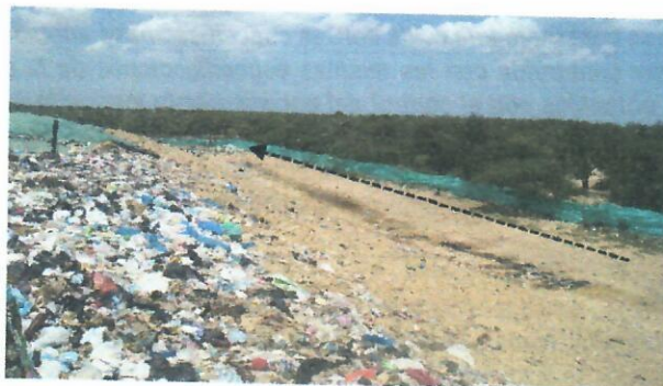
Foto No 18. Fecha 09 de septiembre de 2019. Afloramiento de lixiviado y formación de charcos en costado Norte de nueva celda transitoria.
