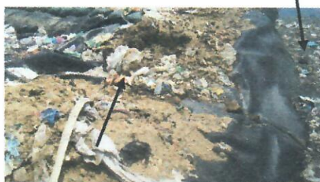
Fotos No 22, 23, 24, 25, 26 y 27. Fecha 09 de septiembre de 2019. Canal en tierra con sectores con geomembrana cubiertos de lixiviados y residuos provenientes de la nueva celda transitoria, costado Oeste.
