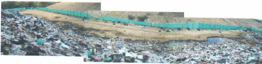
Fotos No 15, 16 y 17. Fecha 09 de septiembre de 2019. Afloramiento y formación de charcos de lixiviado en el costado Este de la nueva celda transitoria.
