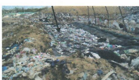
Fotos No 22, 23, 24, 25, 26 y 27. Fecha 09 de septiembre de 2019. Canal en tierra con sectores con geomembrana cubiertos de lixiviados y residuos provenientes de la nueva celda transitoria, costado Oeste.
