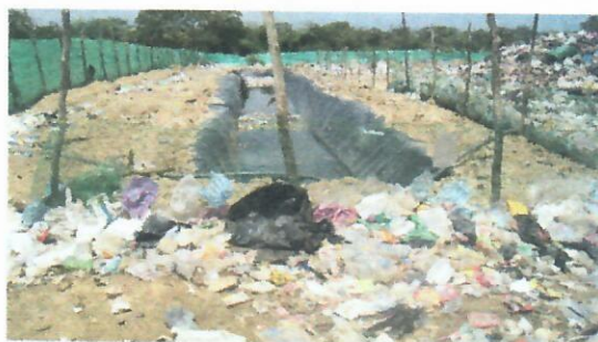
Foto No 30. Fecha 09 de septiembre de 2019. Canal cubierto con geomembrana localizado al sur del área donde se dispone directamente residuos en el suelo, al cual confluyen lixiviados provenientes tanto del canal abierto construido en la base de la nueva celda y del área desnuda donde se dispone directamente al suelo los residuos.
