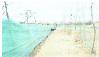
Foto No 32, 33, 34, 35 y 36. Fecha 02 de mayo de 2019. Malla y lona verde de control de residuos en perímetro del sitio de disposición final.
