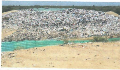
Foto No 14. Fecha 09 de septiembre de 2019. Nueva celda transitoria completamente llena y residuos expuestos sin manejo técnico
