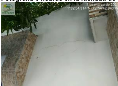
Fotografía 5 fisuras en la fachada de vivienda
